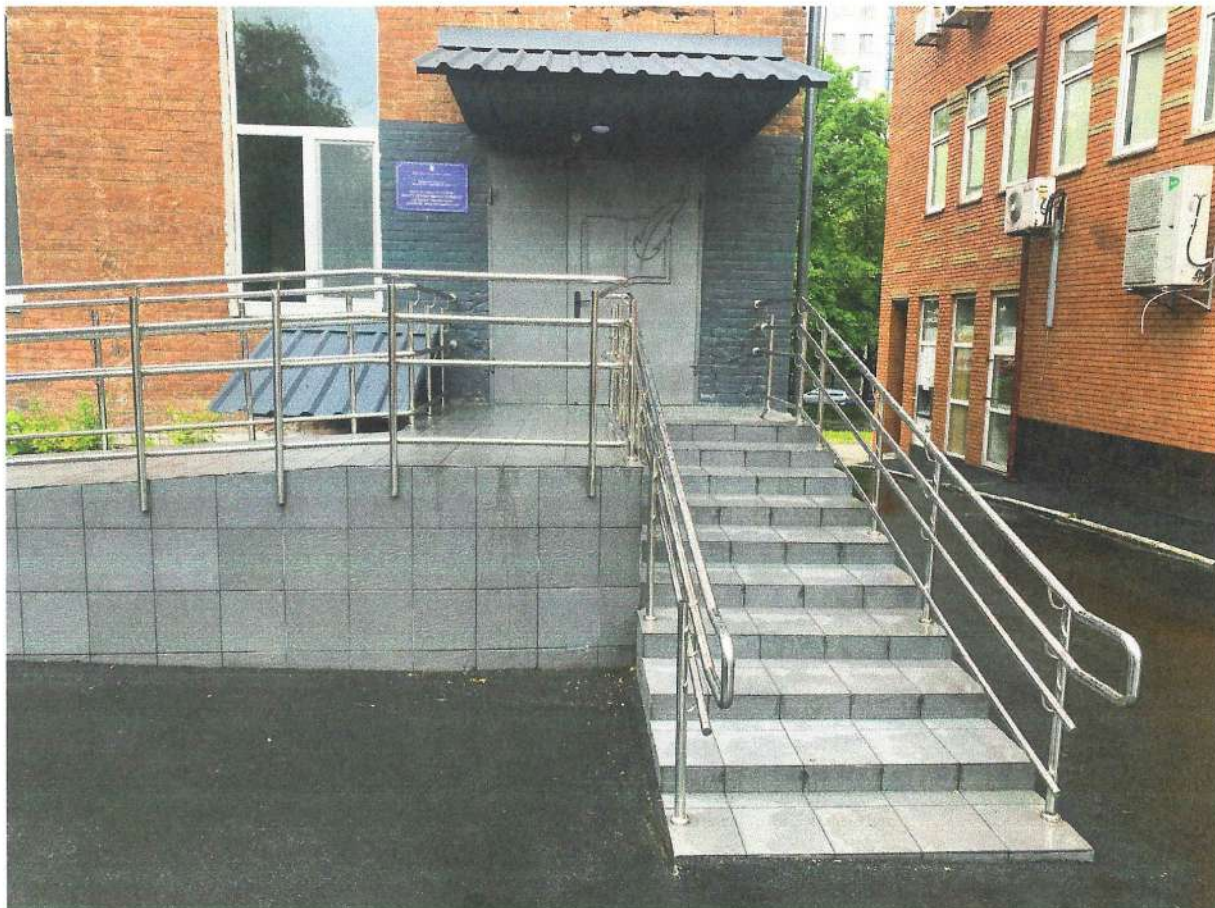
Фото2. Вхід до будівлі. Необхідно виконати маркування, контрасною стрічкою, верхньої та нижньої сходинки сходового маршу.
